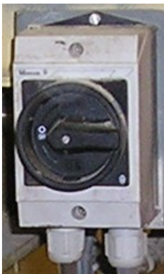
(a) Vergrendelbare AAN/UIT-schakelaar
