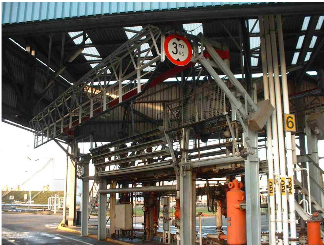
Figuur 5.7 Een collectieve valbeveiliging voor topbelading (Bron: Dejonghe, 2006 [35])
