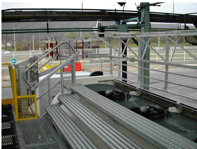
Figuur 5 Een collectieve valbeveiliging voor topbelading (Bron: Seveso Symposium 2006)
